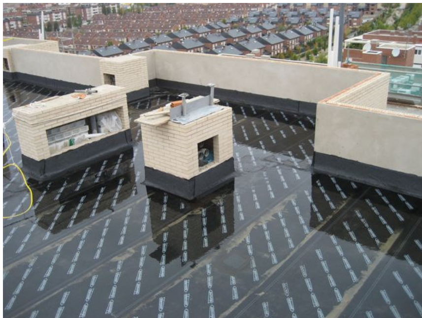
IMPERMEABILIZACION DE CUBIERTAS
